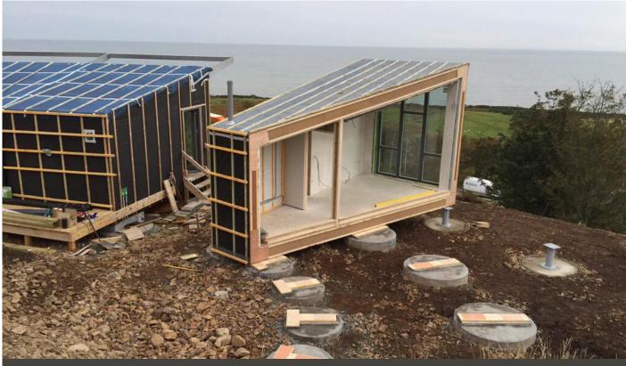
Volumetric module in-situ. Photo: Carbon Dynamic
